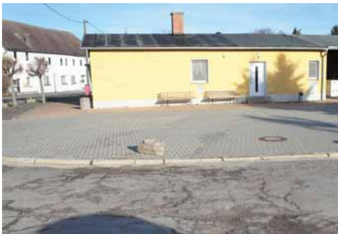
Abb.100.: Derzeitiger Zustand Dorfplatz Sundremda, Quelle: eigene Aufnahme
