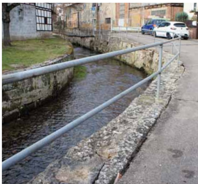
Abb.121.: Derzeitiger Zustand Remdaer Rinne Ammelstädt, Quelle: eigene Aufnahme
