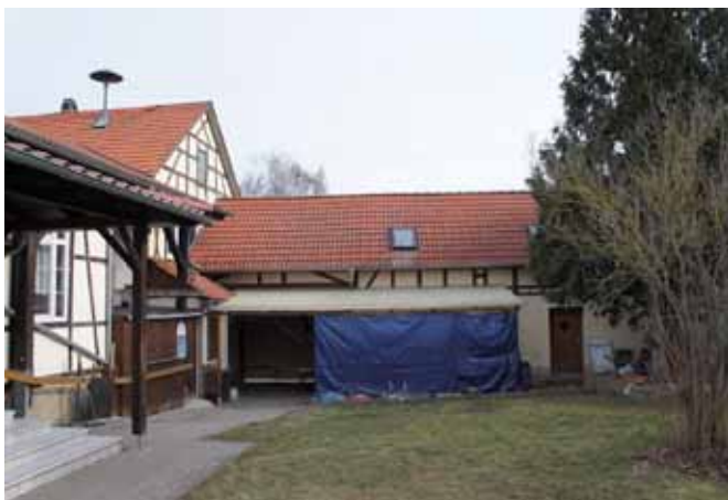
Abb.133.: Gebäude und Außenbereich Dorfgemeinschaftshaus Breitenheerda, Quelle: eigene Aufnahme
