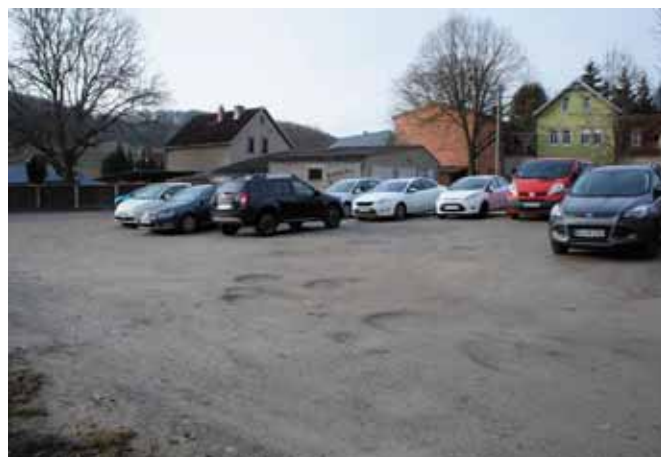
Abb.130.: Derzeitiger Zustand Parkplatz Kindergarten Remda, Quelle: eigene Aufnahme
