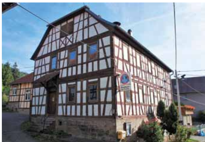
Abb.113.: Kommunales Objekt ehemalige Gaststätte in Milbitz, Quelle: eigene Aufnahme
