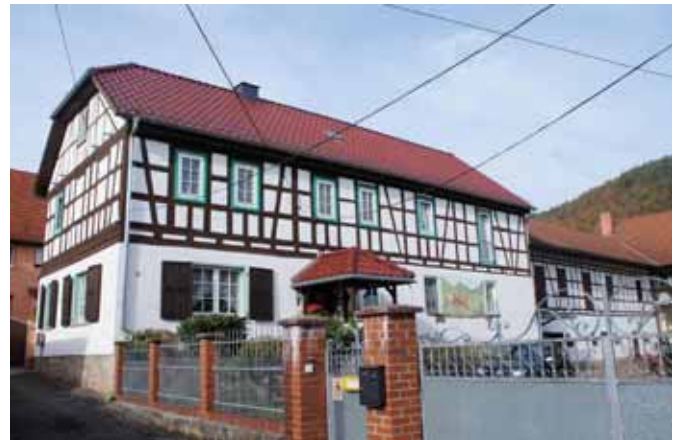
Abb.92.: Beispiel eines ortsbildprägenden Fachwerkgebäudes in Teichröda, Quelle: eigene Aufnahme
