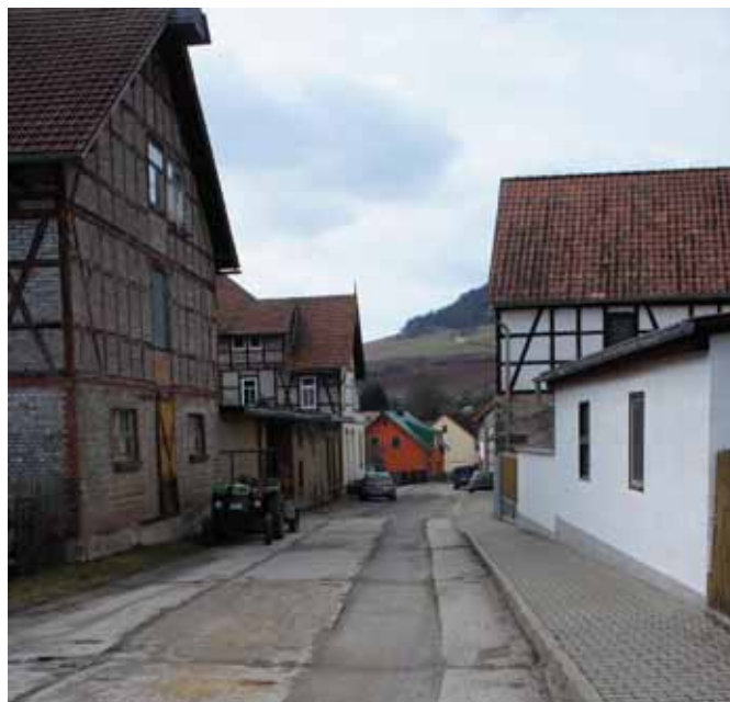
Abb.110.: Straßenzustand Molkereistraße Teichel, Quelle: eigene Aufnahme
