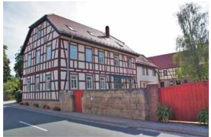
Abb.87.: Saniertes Fachwerkgebäude in Breitenheerda, Quelle: eigene Aufnahme
