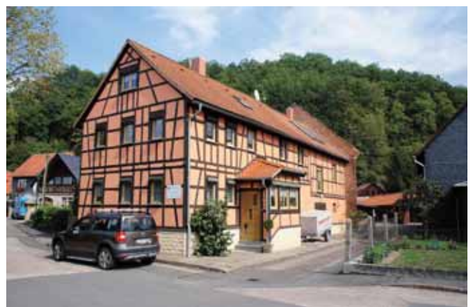
Abb.88.: Satteldach auf Fachwerkgebäude in Ammelstädt, Quelle: eigene Aufnahme
