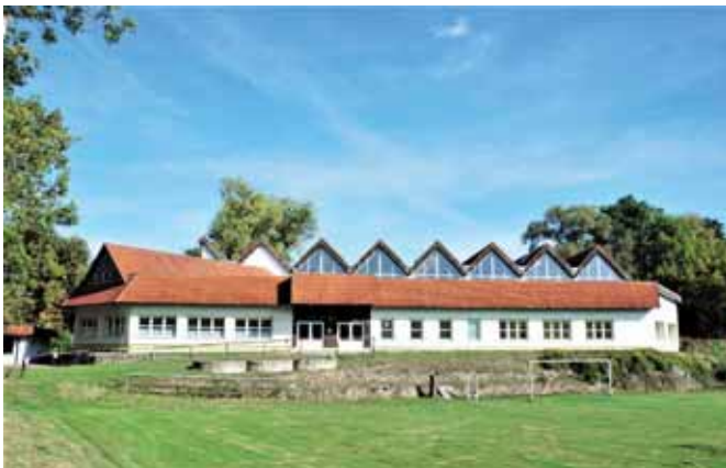
Abb.66.: Haus der Vereine in Remda, Quelle: eigene Aufnahme
