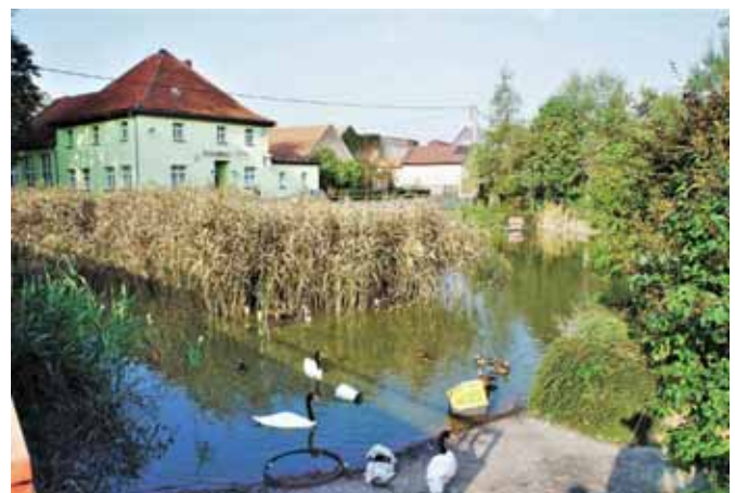
Abb.118.: Feuerlöschteich Treppendorf, Quelle: eigene Aufnahme
