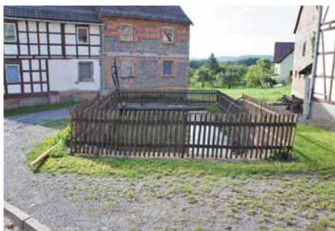
Abb.119.: Feuerlöschteich Milbitz, Quelle: eigene Aufnahme
