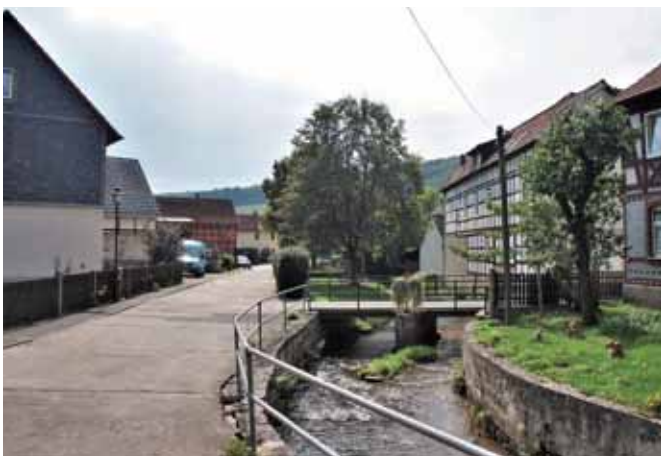
Abb.34.: Ortsmitte Ammelstädt, Quelle: eigene Aufnahme
