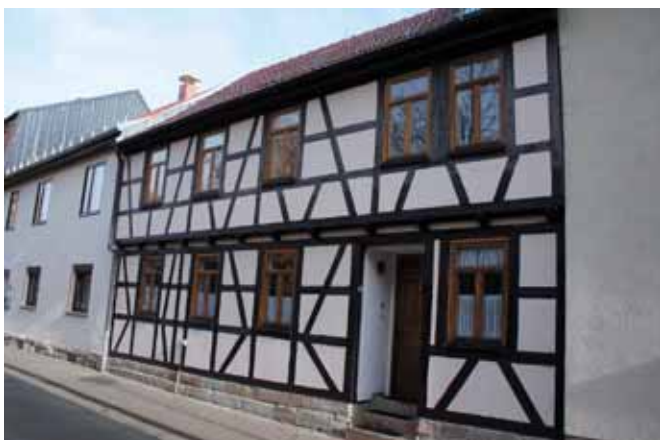
Abb.89.: Typische Materialien an Fachwerkgebäude in Remda, Quelle: eigene Aufnahme
