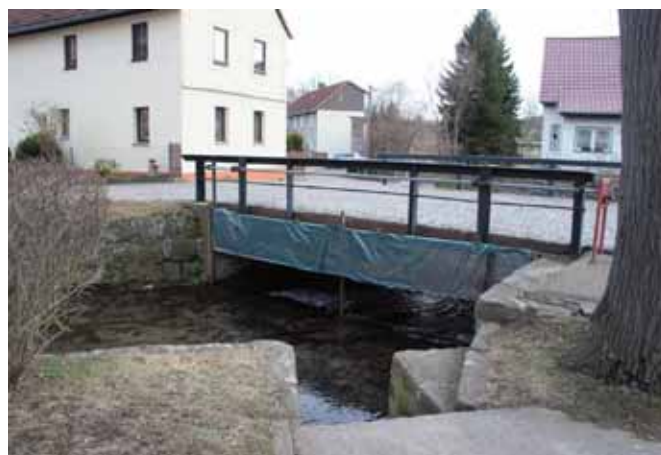
Abb.122.: Löschwasserentnahmestelle Ammelstädt, Quelle: eigene Aufnahme
