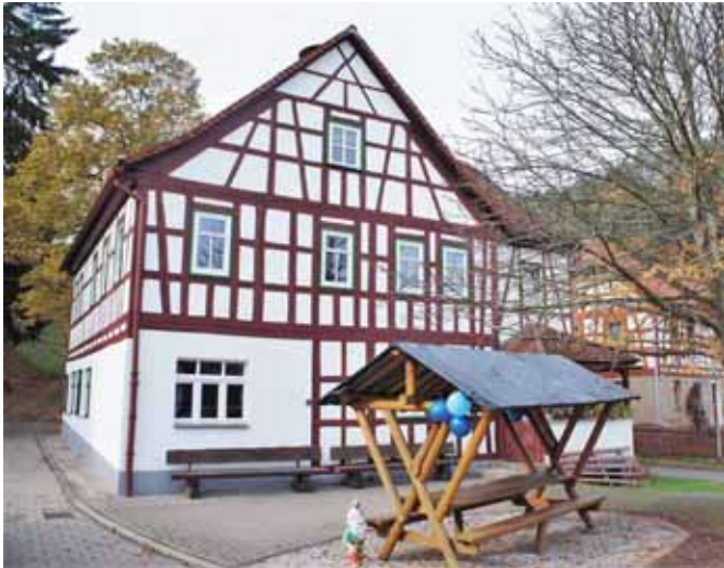
Abb.20.: Dorfgemeinschaftshaus Geitersdorf, Quelle: eigene Aufnahme
