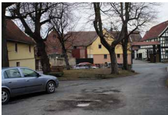
Abb.105.: Derzeitiger Zustand Dorfplatz Haufeld, Quelle: eigene Aufnahme
