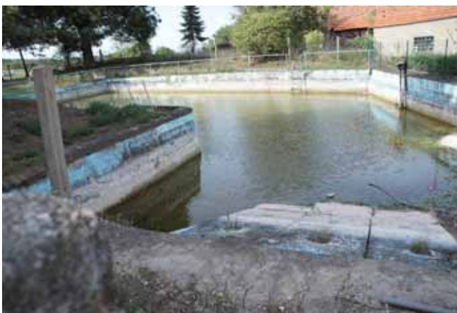
Abb.115.: Derzeitiger Zustand Feuerlöschteich Breitenheerda, Quelle: eigene Aufnahme
