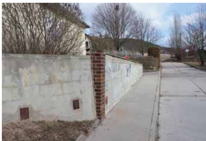
Abb.129.: Derzeitiger Zustand Zuwegung und Umfeld Kindergarten Teichel, Quelle: eigene Aufnahme
