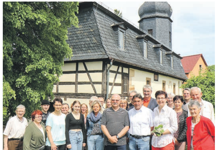
Die Buchaer Kirchgemeinde freut sich über die neue Läuteanlage für die Annenkirche, die dank Spenden- und Lottomitteln ermöglicht wurde. (Foto: PL)
